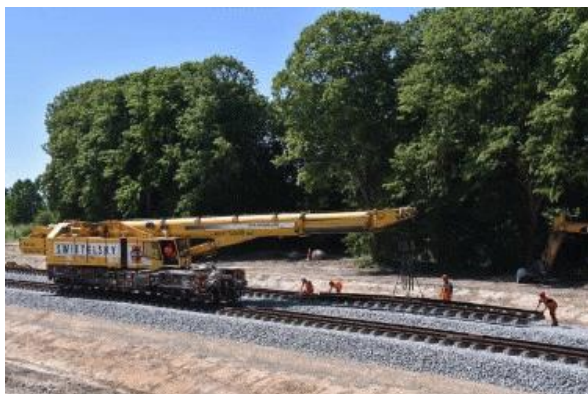
Kranen i arbejde med at lægge sporrammer på plads i Rm (Herlufmagle), mandag 15. juni 2020.
